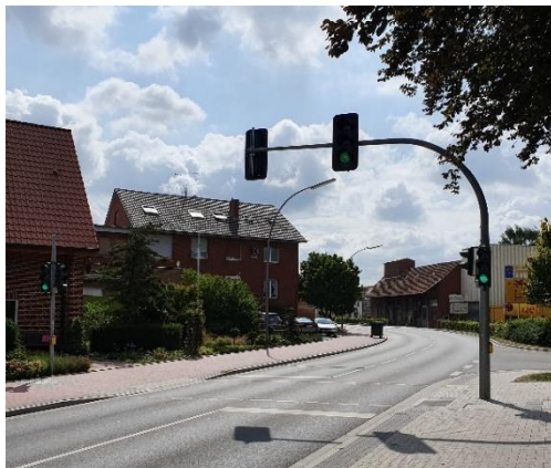
Abb. 21: Lichtsignalanlage. (Quelle: planinvent 2019)
